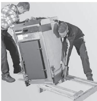
Fig. 13 Rimuovere la caldaia dal pallet
