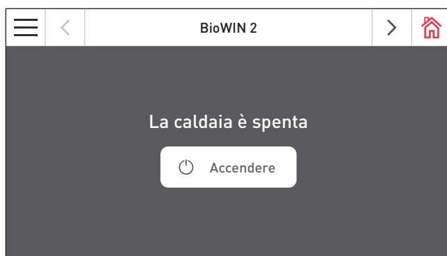
Fig. 54 La caldaia è spenta
