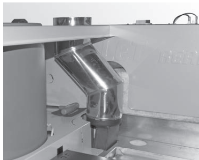
Fig. 157 Inserir il raccordo gas combusti
