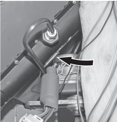
Fig. 102 Introdurre completamente la sonda per il termostato di sicurezza del tubo della coclea
