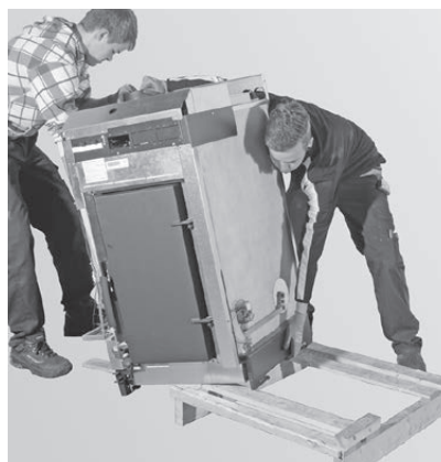
Fig. 15 Rimuovere la caldaia dal pallet
