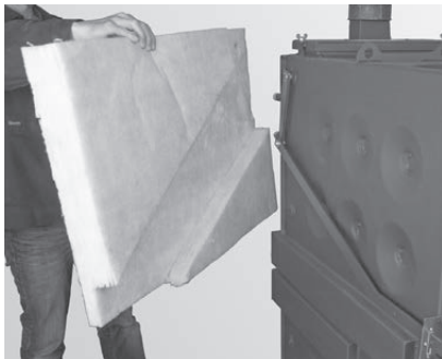
Fig. 57 Montare gli isolamenti
