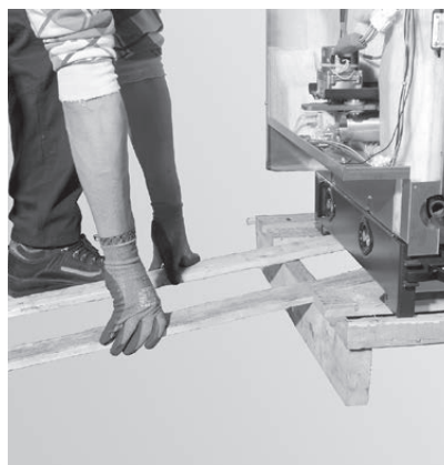
Fig. 13 Collocare le assi della gabbia a mo' di rampa
