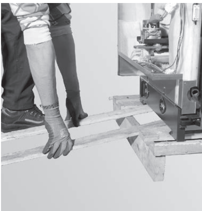
Fig. 9 Collocare le assi della gabbia a mo' di rampa
