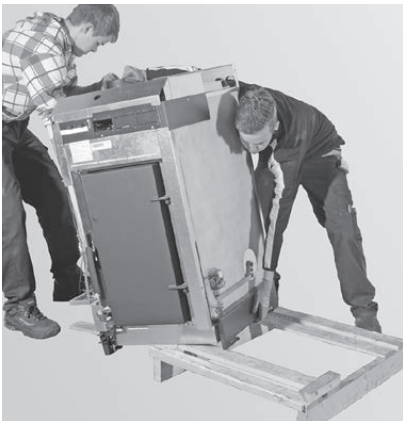
Fig. 11 Staccare la caldaia dal pallet
