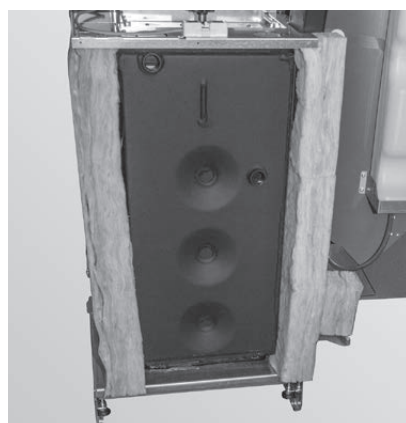
Fig. 60 Parete posteriore rimossa
