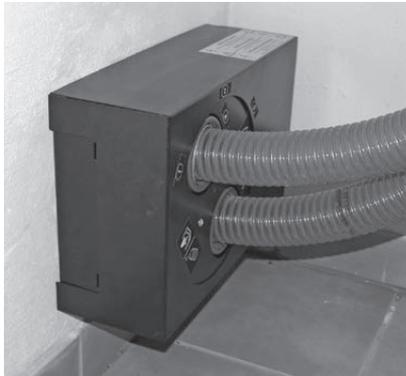
Fig. 27 Fissare i tubi flessibili con le fascette di serraggio e montare la copertura
