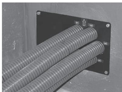
Fig. 19 Infilare i tubi flessibili – Lato magazzino
