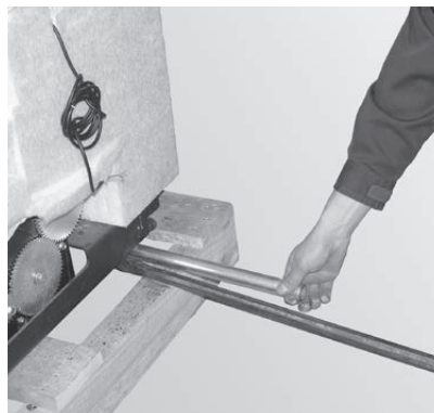
Fig. 13 Collocare la barra di ferro sotto la caldaia
