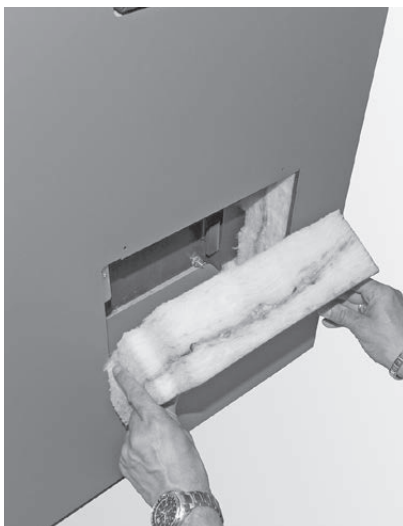
Fig. 55 Inserire l'isolamento in corrispondenza dell'apertura per la pulizia
