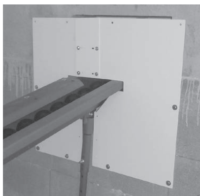
Fig. 174 Montare le lamiere di copertura all'interno
