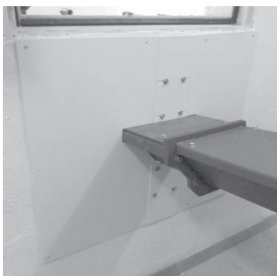
Fig. 175 Montare le lamiere di copertura all'esterno
