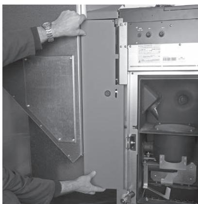
Fig. 81 Infilare il rivestimento anteriore
