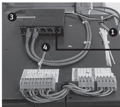
Fig.128 Switch con collegamento LAN e morsettiere
