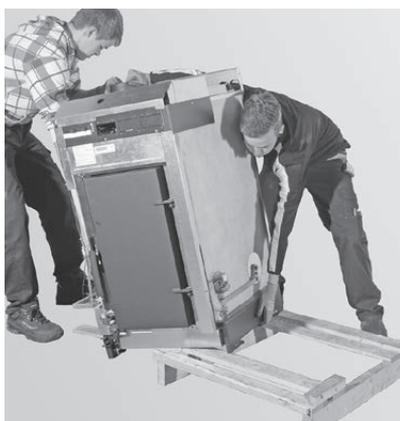
Fig. 13 Rimuovere la caldaia dal pallet
