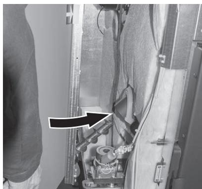
Fig. 43 Infilare la coclea di alimentazione in basso accanto al tubo della coclea
