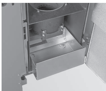
Fig. 40 Estrarre il recipiente per la cenere 1 e metterlo davanti alla caldaia
