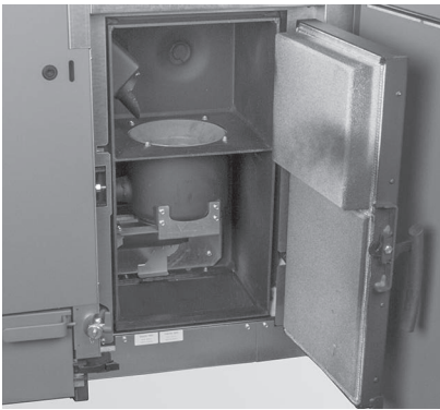
Fig. 37 Aprire la porta di contenimento e lo sportello della camera di combustione
