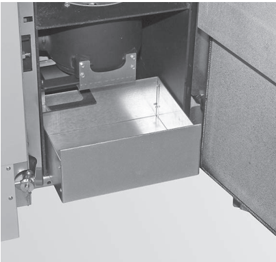
Fig. 38 Estrarre il recipiente per la cenere e metterlo davanti alla caldaia
