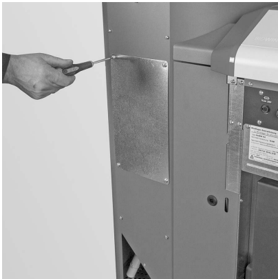
Fig. 83 Rimuovere le viti, togliere il coperchio di revisione
