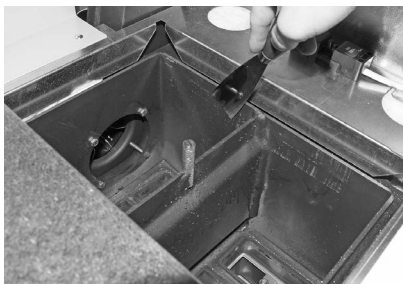
Fig. 72 Pulire le superfici riscaldanti
