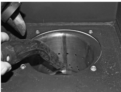
Fig. 55 Aspirare il corpo caldaia
